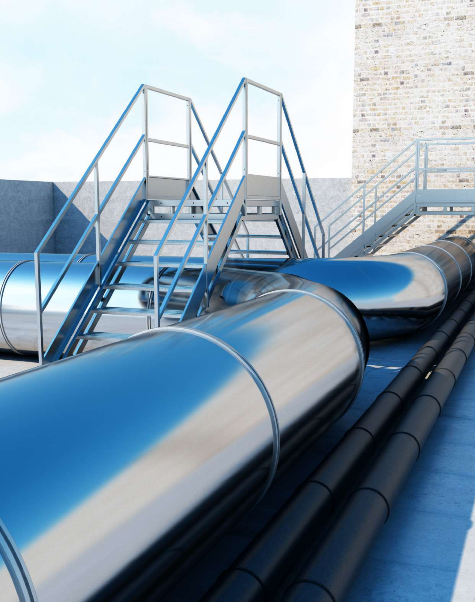
Passerella di scavalco su complesso industriale articolato
